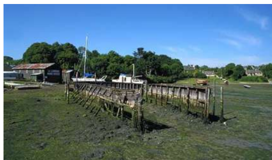
修復前の乾船渠
