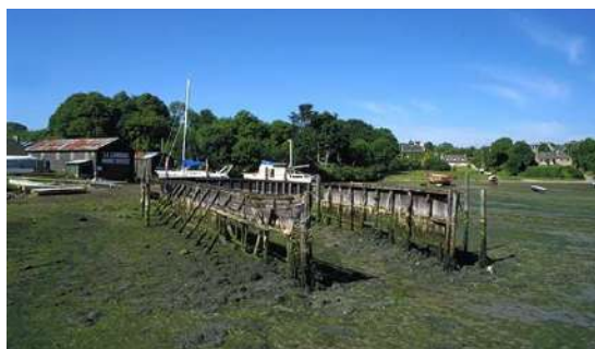
修復前の乾船渠
