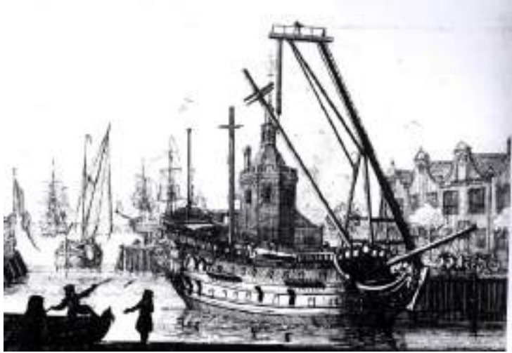
帆柱の据え付け
