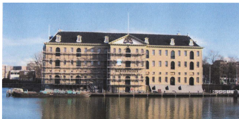
改修中の博物館
